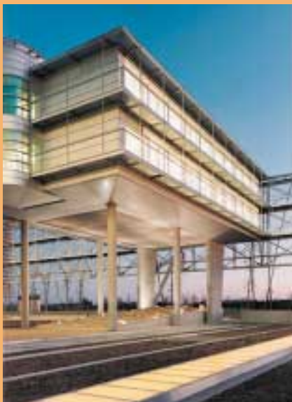
Eine von insgesamt acht zweigeschossigen Büro-Units der Swiss Re
