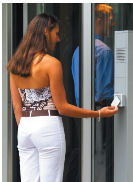
Beispiel für Zutrittskontrolle an einem RFID-basierten Leser mit hinterlagerter Vereinzelungseinrichtung
