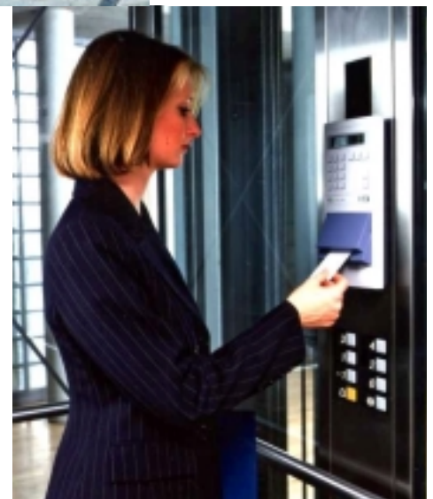
Bild 2 (unten): Die ZK im Fahrstuhl verhindert das Anfahren verbotener Etagen
