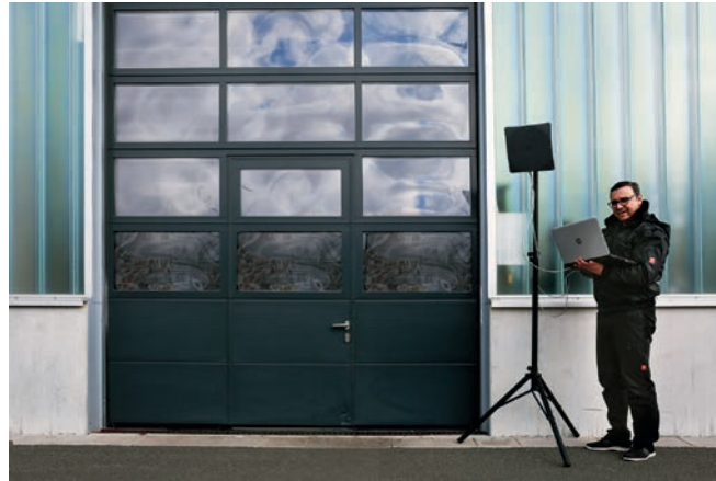
Bild 2: Neben der Standortbegehung ist auch eine Testinstallation die Voraussetzung dafür, dass die Zufahrtskontrolle in der Praxis einwandfrei funktioniert
