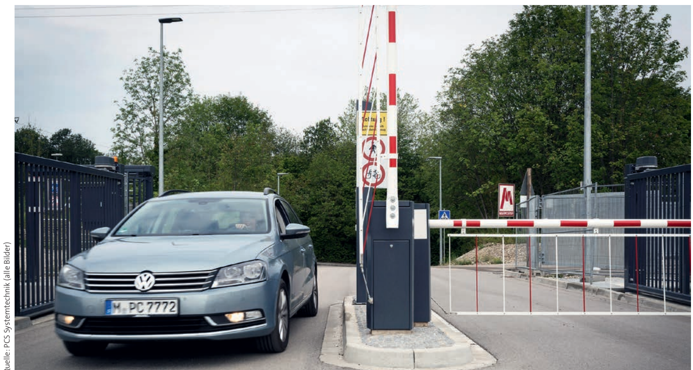
Bild 1: Für die automatische Schrankenöffnung über UHF-Weitbereichsleser muss definiert werden, welche Art von Fahrzeugen (Autos, LKWs oder auch Fahrräder) passieren sollen
