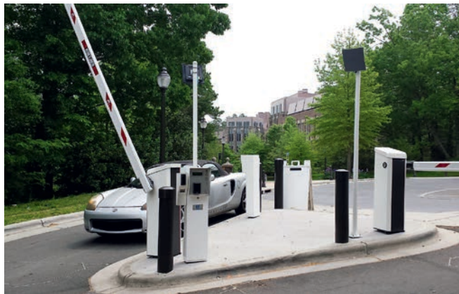
Bild 3: Kommen Fahrzeuge unterschiedlicher Größe aus verschiedenen Richtungen, kann für eine optimale Erfassung der Einsatz zweier Weitbereichsleser notwendig werden
