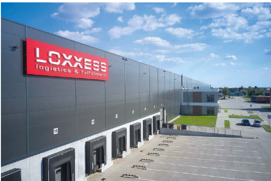
Loxxess betreibt ab Ende 2022 im tschechischen Bor eine neue Logistikhalle mit 68.000 m 2 Fläche
