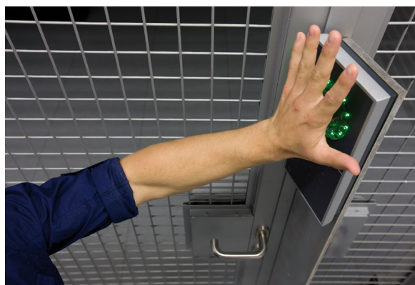
Bei einer Multifaktor-Authentifizierung werden zwei Merkmale zur Zutrittskontrolle abgefragt, hier das individuelle Handflächenvenenmuster und ein PIN.
