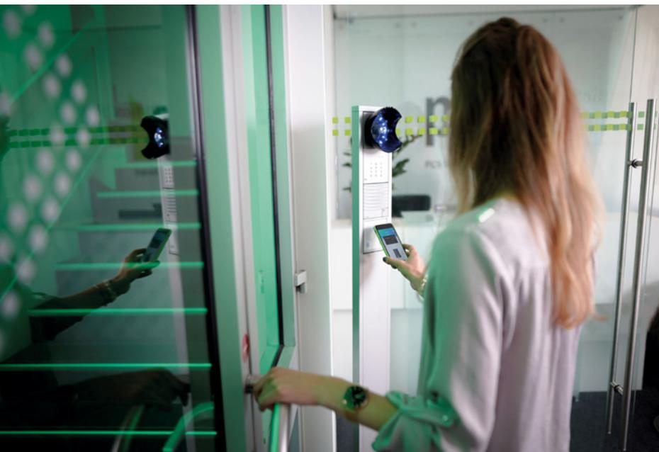
Abb. 4: Zutrittsstelle mit der Möglichkeit der Mehrfach-Authentifizierung mittels PIN, Ausweis/Smartphone und/oder Handvenenerkennung
