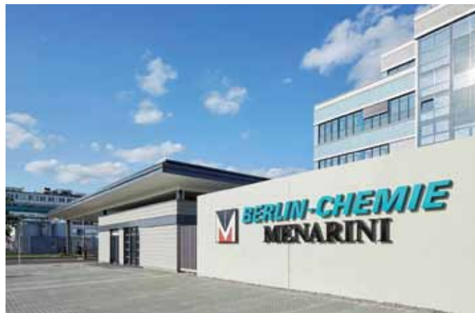
▲ Als KRITIS-Unternehmen modernisierte die Berlin-Chemie AG ihre Zutrittskontrolle grundlegend – beginnend am Firmeneingang. Foto: Berlin-Chemie AG
